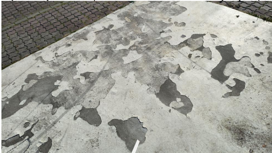
Cała powierzchnia wymaga frezowania, naprawy i profilacji
