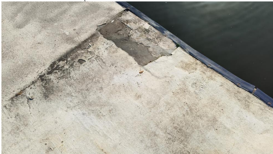
Krawędź pomostu wymaga odbudowy łącznie z obróbką i wymianą odbojnic
