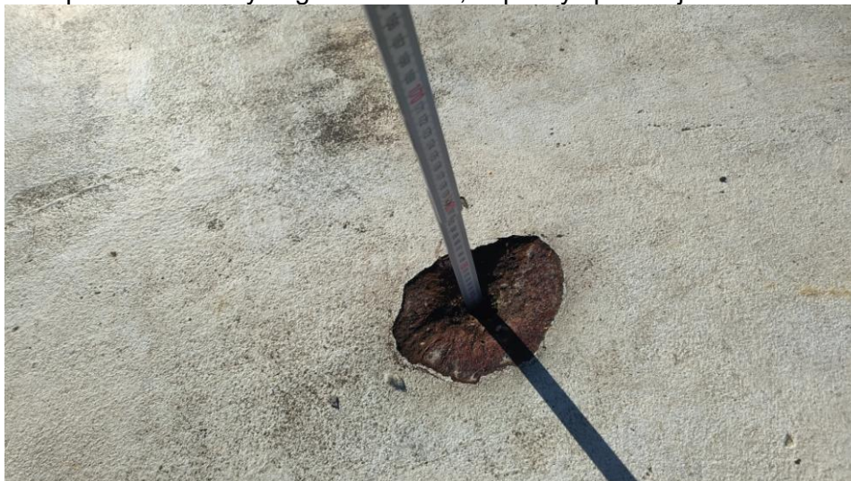
Miejscowe głębokie ubytki betonu
