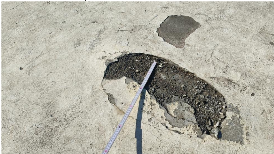
Głębokie ubytki betonu spowodowane warunkami atmosferycznymi i przemarzaniem
