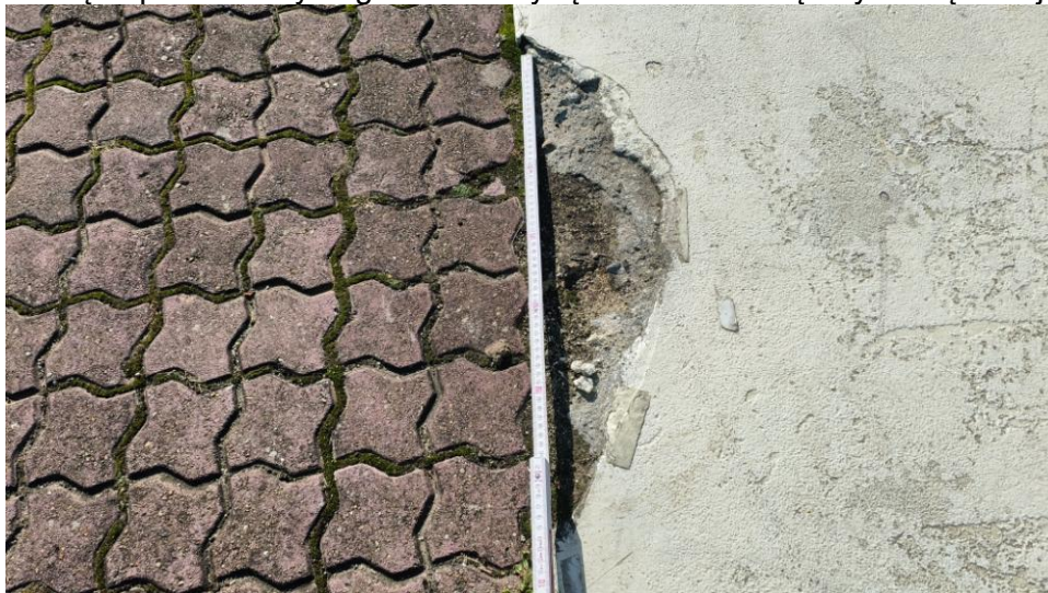
Uszkodzone krawędzie betonu na połączeniu z kostką brukową, brak wzmocnienia np. płaskownikiem lub kątownikiem stalowym
