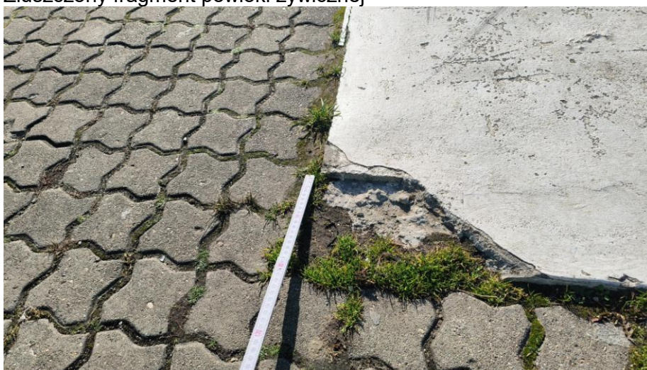
Uszkodzone fragmenty konstrukcji betonowej pirsów wymaga naprawy w technologii STO, Sika lub równoważnych
